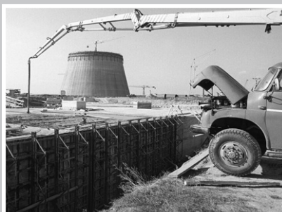
Výstavba chladičích věží a betonáž základové desky
