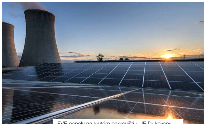
FVE panely na krytém parkovišti u JE Dukovany
