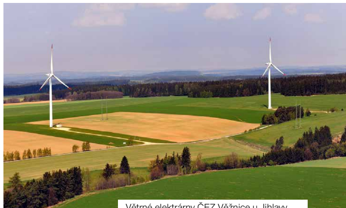
Větrné elektrárny ČEZ Věžnice u Jihlavy
