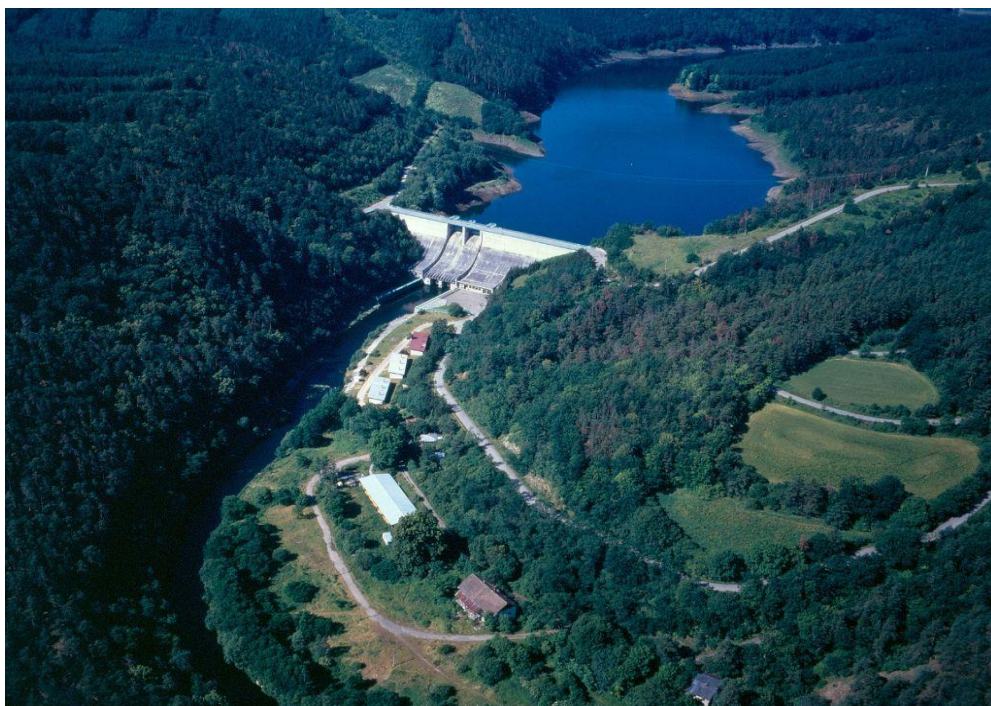
Obr. 6 Letecký snímek - pohled na MVE Mohelno [4]
