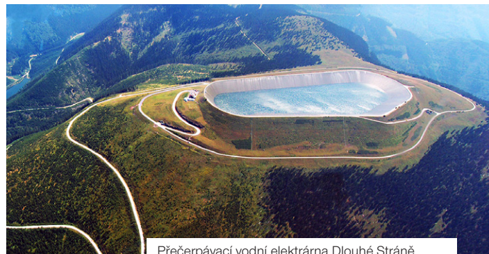
Přecherčpávací vodní elektrárna Dlouhé Stráně
