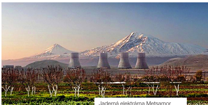
Jaderná elektrárna Metsamor
