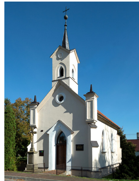
Kaple sv. Rodiny po celkové rekonstrukci
