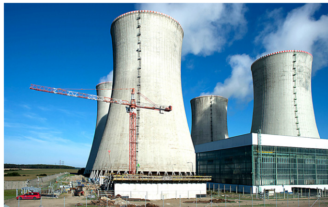
Stavba koncového jmače tepla pro HVB I - stav v srpnu letošního roku
