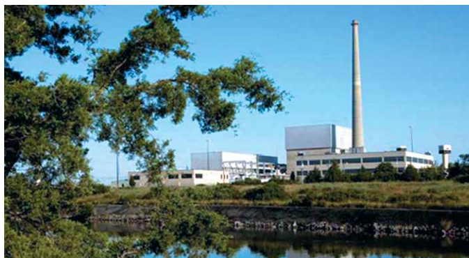
Jaderná elektrárna Oyster Creek
