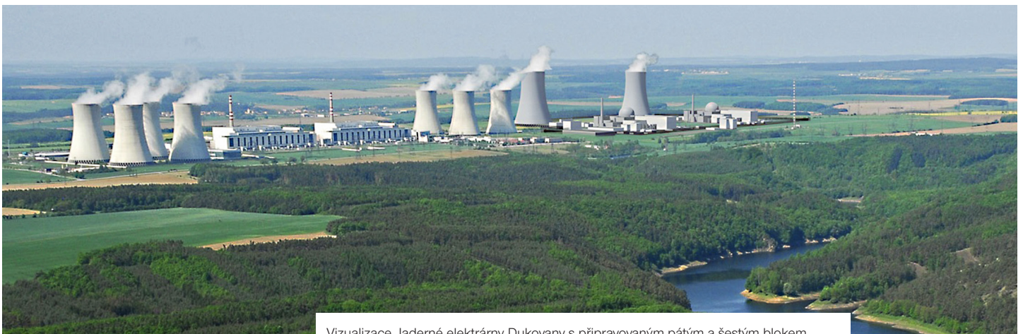
Vizualizace Jaderné elektrárny Dukovany s připravovaným pátým a šestým blokem
